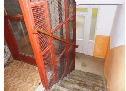
vstupné zádverie so schodiskom
