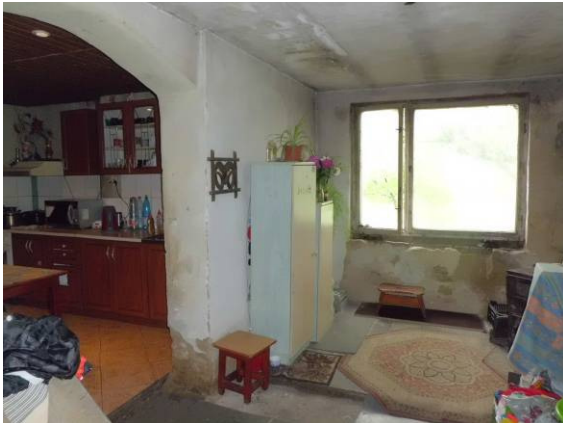
Vstupná hala – detail konštrukcií
