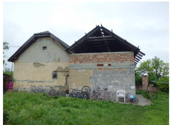
Pravý bočný pohľad na RD
