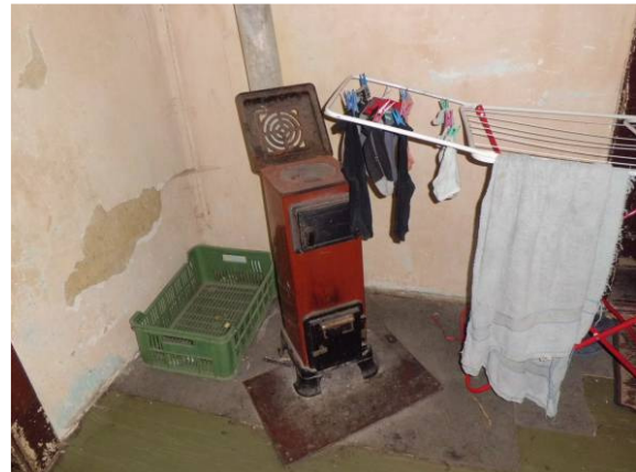
Izba – detail konštrukcií
