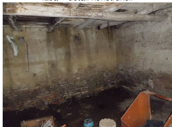
Chliev – detail konštrukcií
